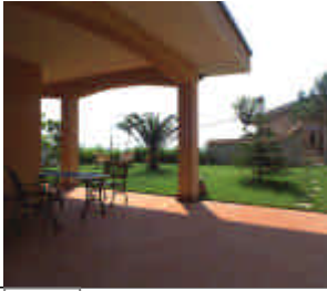
Sopra | Porticato con pavimentazione in regolino 6x3x27. Accanto | Percorsi pedonali realizzati con regolino 6x3x27 e mattoncini. Sotto | Il progetto visto in pianta della sistemazione esterna.
